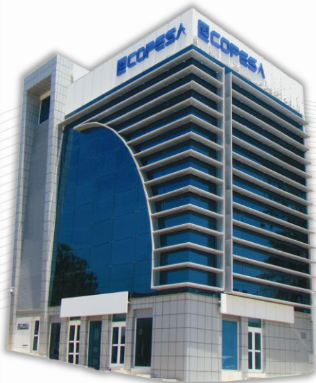
Edificio Corporativo COPESA
